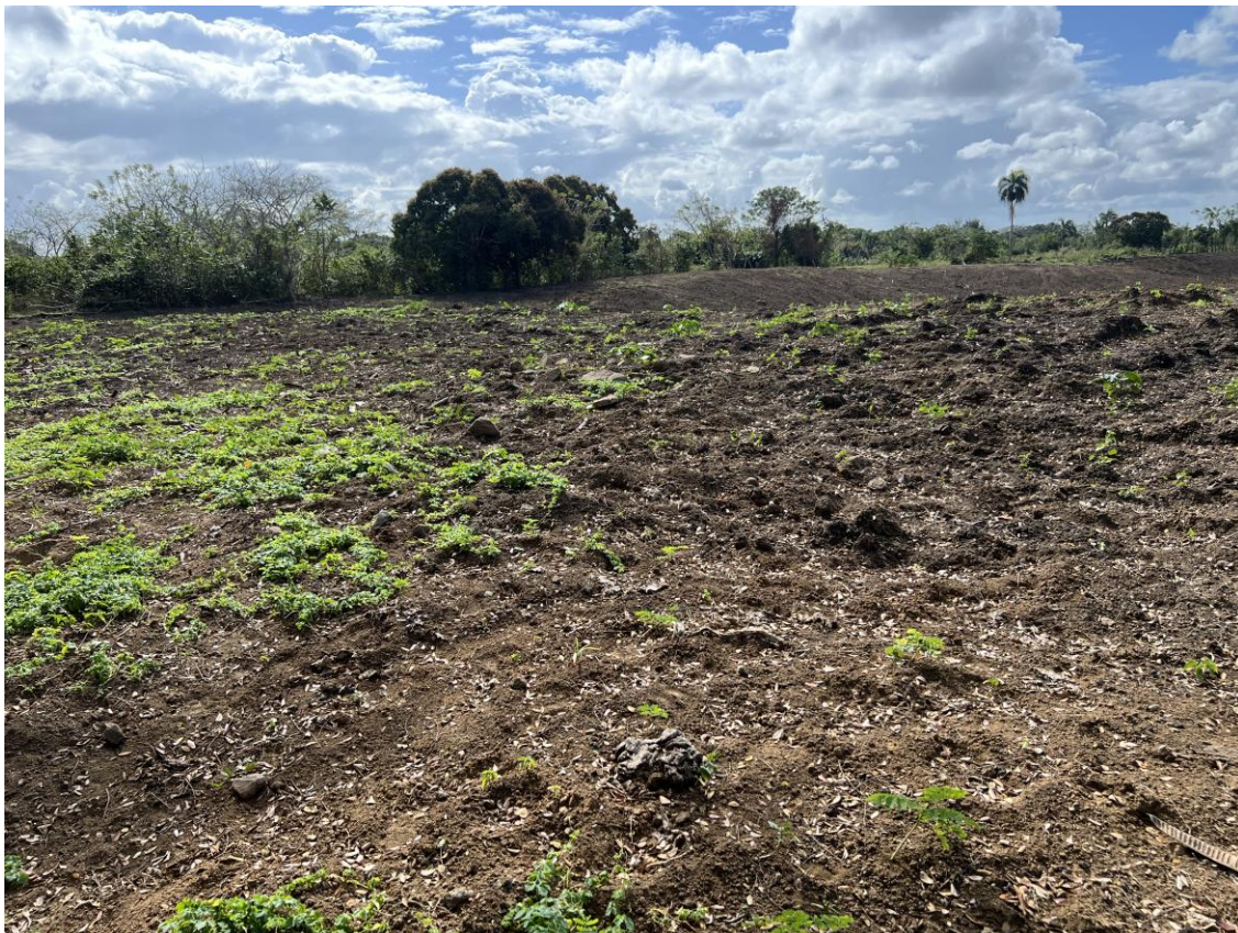
Adecuación de Talud de Área Recuperada y capa vegetal para cierre
